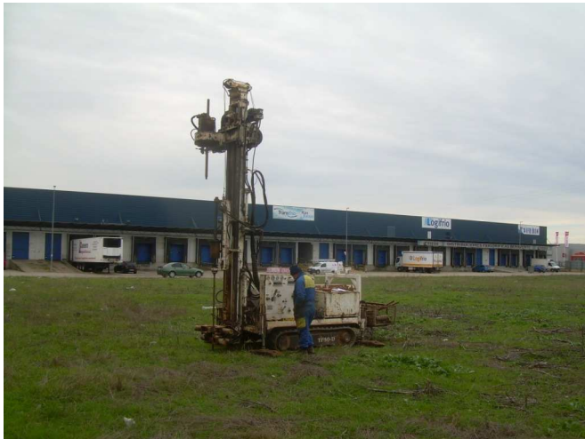
Emplazamiento de S-2.
